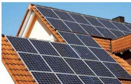
Painel solar convencional
